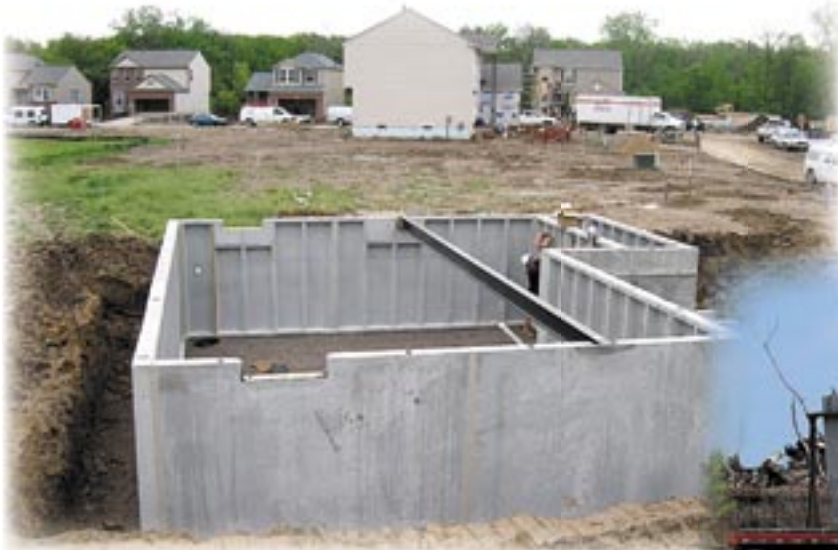
La préfabrication s'étend aussi à la construction de fondations en béton
